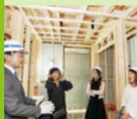
上階での音が気にならないよう吊天井(構造体から離して吊り木で竿縁を吊り、天井板を上に乗せた天井)構造を採用。さらに天井の断熱材には吸音性に優れた断熱材を使用することで、各階の音が反響しにくい工夫がなされています。
