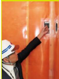
より高い気密性のために、気密コンセントBOX、防湿シート、気密テープを使用し、コンセント穴からの湿気や外気の流れ込みを防ぎます。
